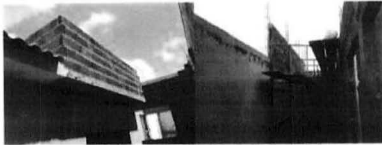
Fig.4 – Elevação da platibanda nos fundos da edificação
