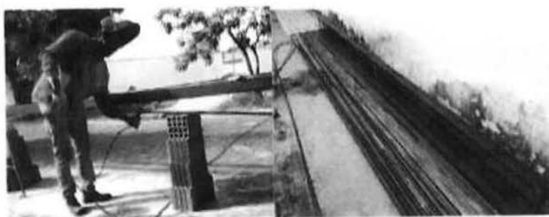
Fig 6 – Montagem das treliças da cobertura.
