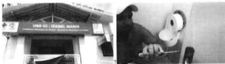
Fig.1 – Reparo na maçaneta do banheiro.
