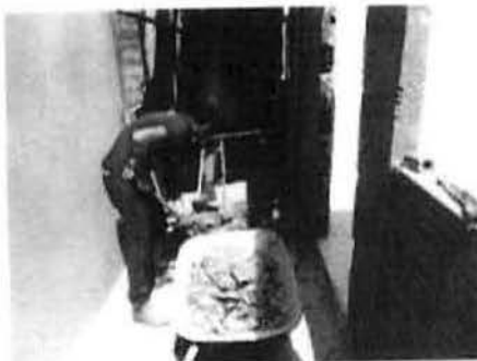
Fig.8 – Remoção de entulhos da obra.
