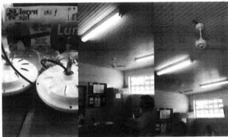
Fig. 5 – Instalação de 02 ventiladores na UBS 01.
