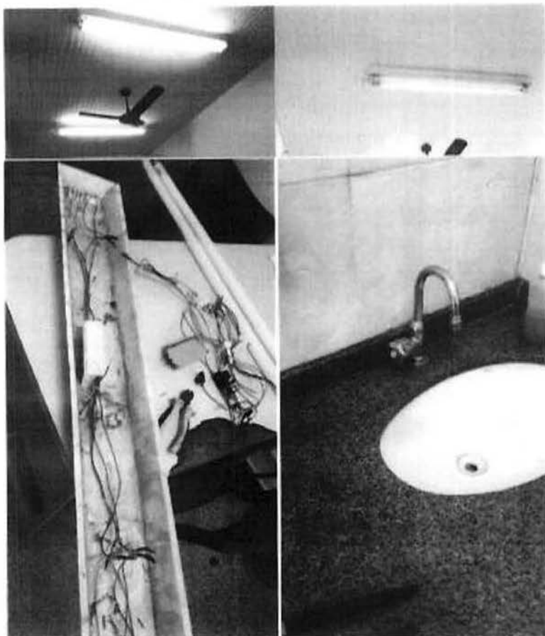
Fig.4 – Manutenções realizadas na UBS 01.
