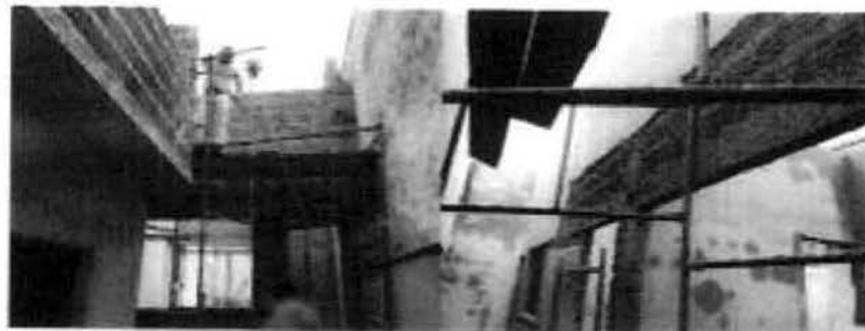
Fig.3 – Execução do reboco externo
