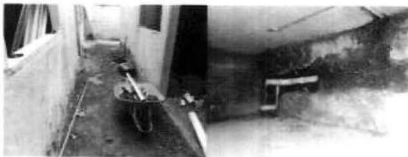
Fig. 4 – Montagem dos ramos de esgoto
