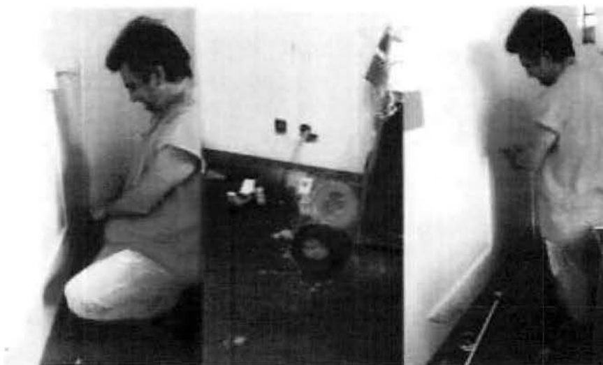
Fig.2 – Instalação de tomada na lavanderia.
