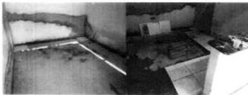
Fig.3 – Assentamento de piso
