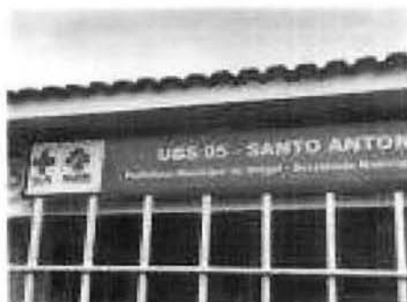
Fig. 1 – Vista Externa da UBS
