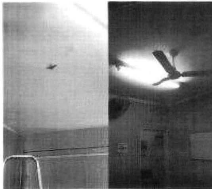
Fig. 28 – Instalação de 02 ventiladores.
