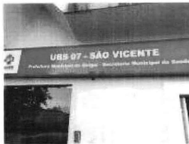
Fig. 9 - Fachada da UBS.
