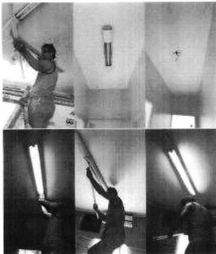
Fig. 29 – Substituição de lâmpadas
