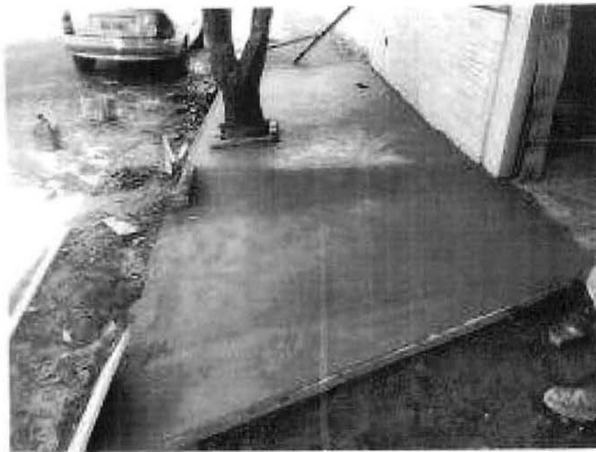
Fig.7 - Concretagem da calçada.
