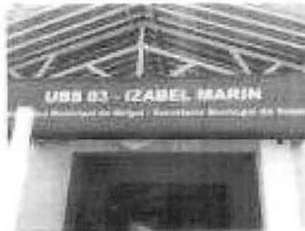
Fig. 4 – Vista da fachada da UBS.
