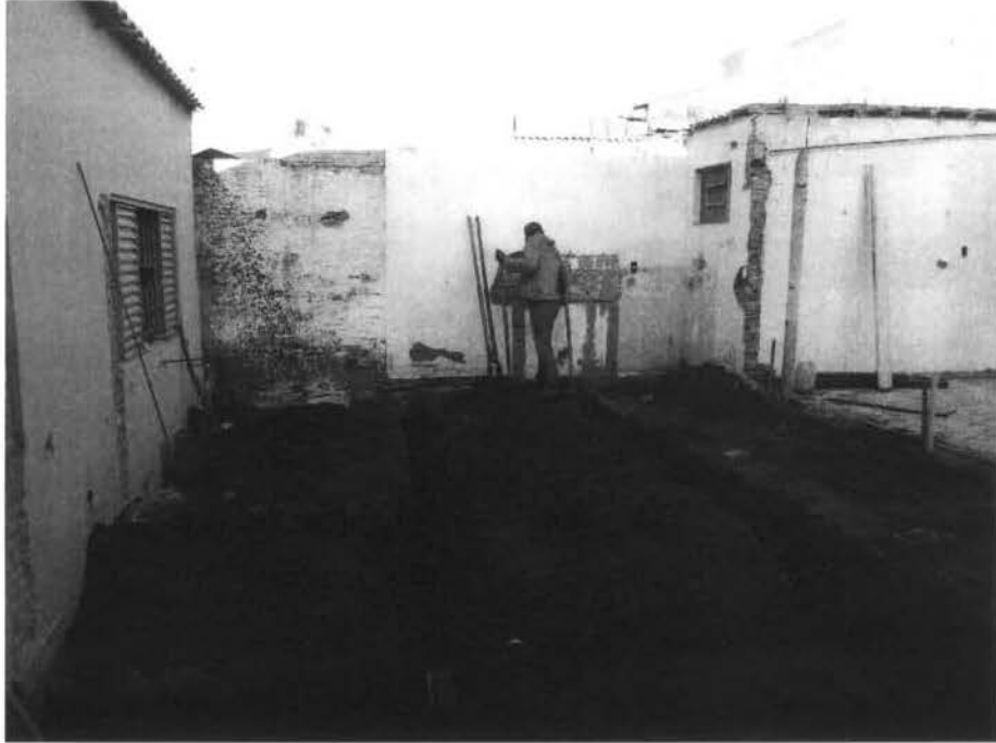
Fig.7 – Local onde será construído: (sala de curativo, lavanderia, copa e banheiro de funcionários).
