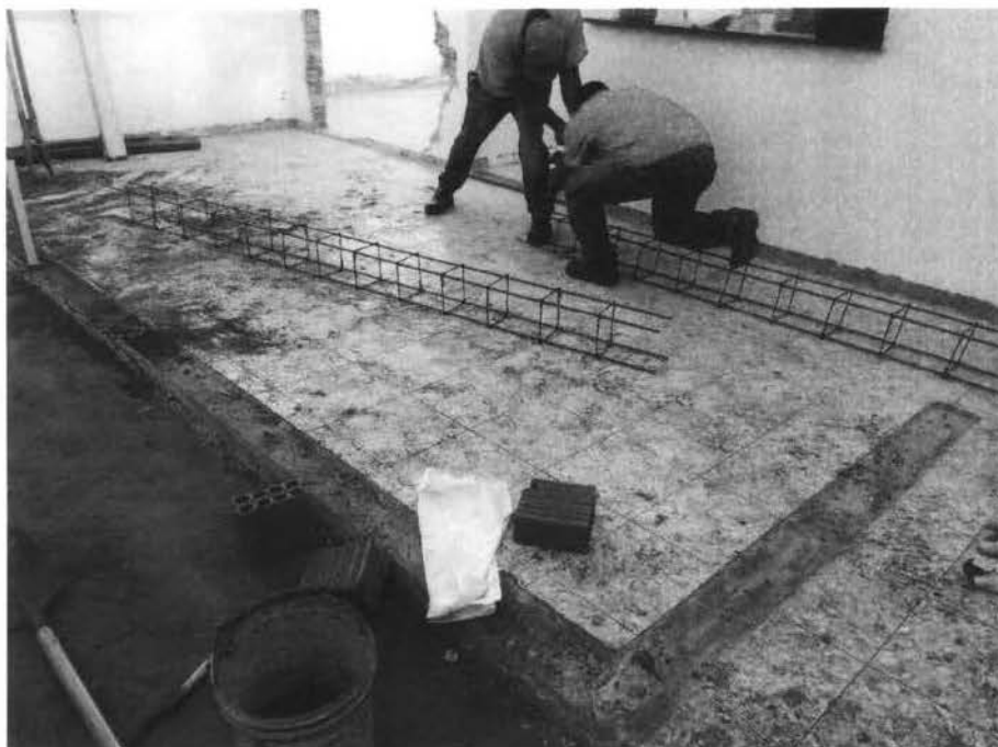
Fig.2- Montagem das armaduras em aço da viga baldrame.
