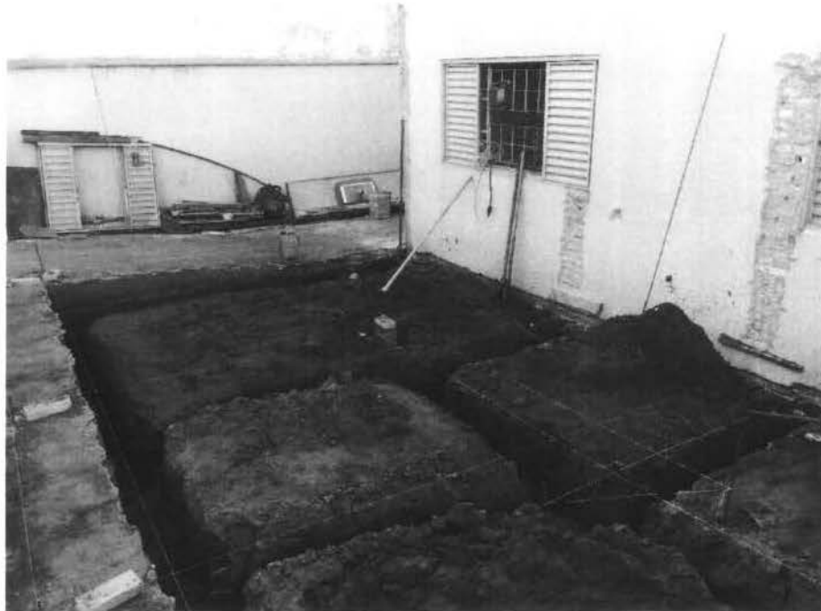
Fig.5- Abertura de vala para execução do baldrame.
