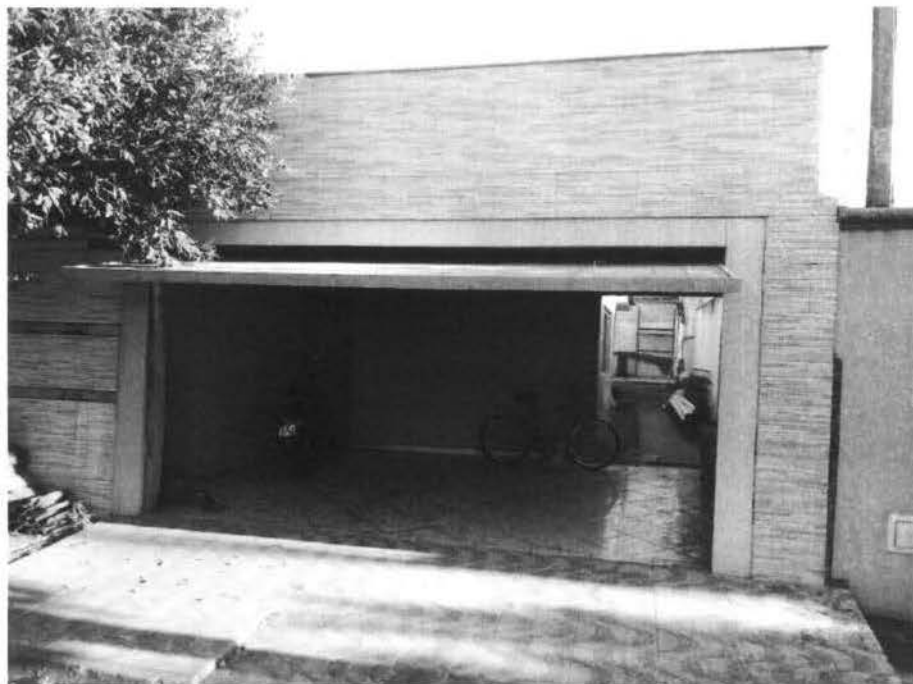
Fig.1 – Fachada da Edificação onde será instalada a nova UBS 08.
