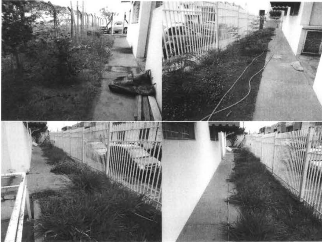
Figura 3 – Jardim da UBS antes dos serviços de roçada.
