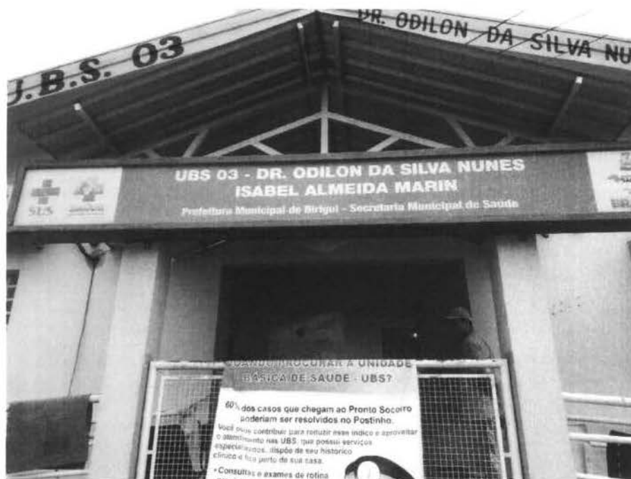
Figura 1- Fachada da UBS 03 – Isabel Marin.
