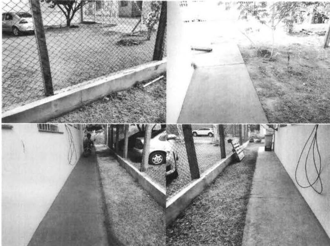
Figura 5 – Fotos após o término dos trabalhos de capina e roçada.
