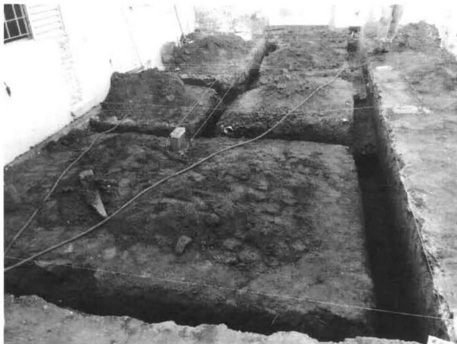
Fig.6- Abertura de vala e broca de fundação.
