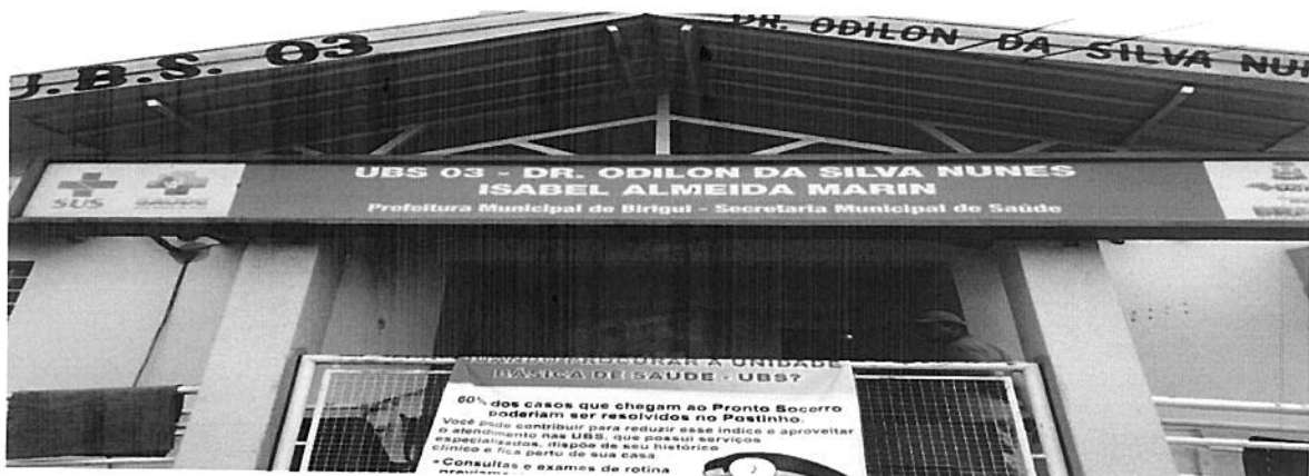
*Figura 1- Fachada da UBS 03 – Isabel Marin.
