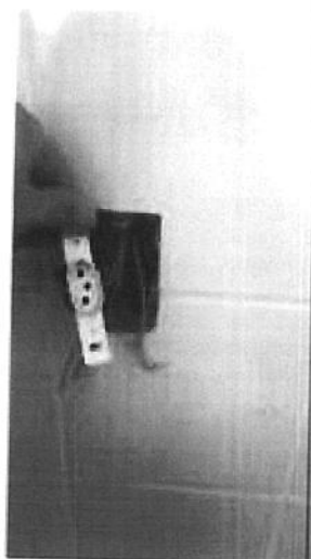
Fig. 5 – Substituição de 01 tomada na cozinha
