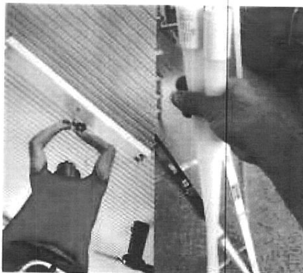
Fig.1 – Substituição de lâmpadas | UBS 01
