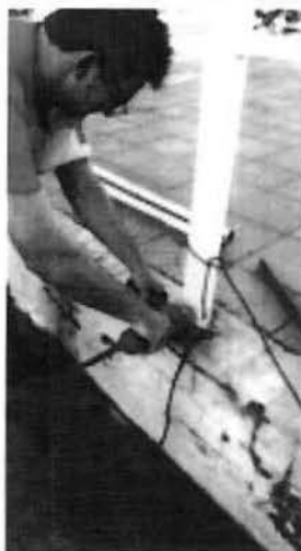
Fig.2 – Reparo e solda do corrimão da fachada da UBS 02
