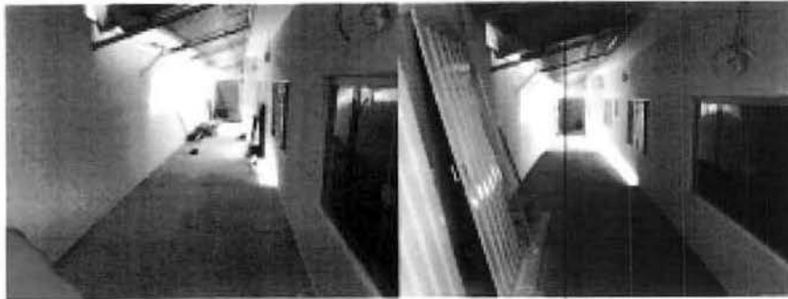
Fig. 9 – Vista do corredor lateral.
