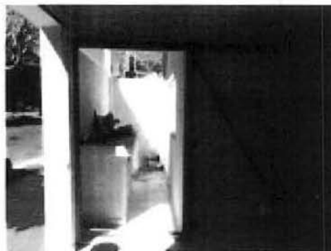
Fig 5 – Vista da porta do corredor lateral (acesso à lixeria)
