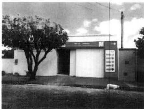
Fig. 1 – Vista da fachada da nova UBS 08.
