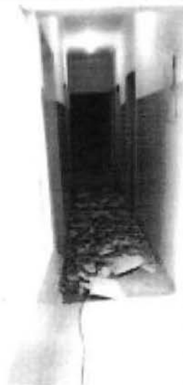
Fig 3 – Remoção do revestimento cerâmico do corredor da edificação principal
