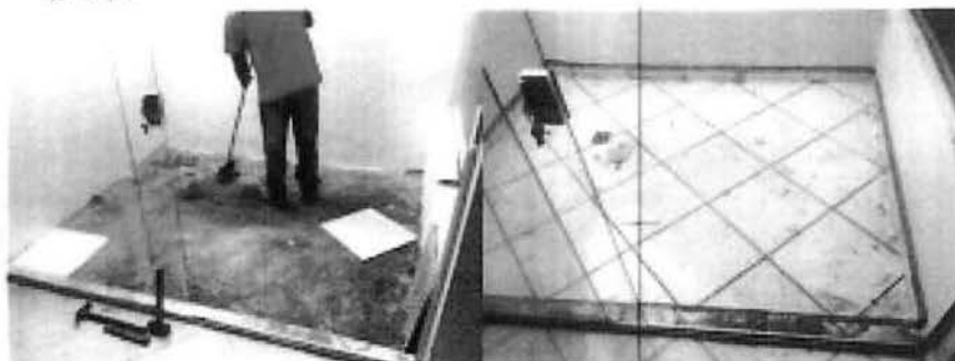
Fig 2 – Assentamento de piso no jardim de inverno
