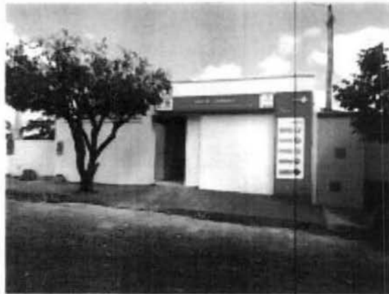
Fig. 15 – Vista da fachada da nova UBS 08.
