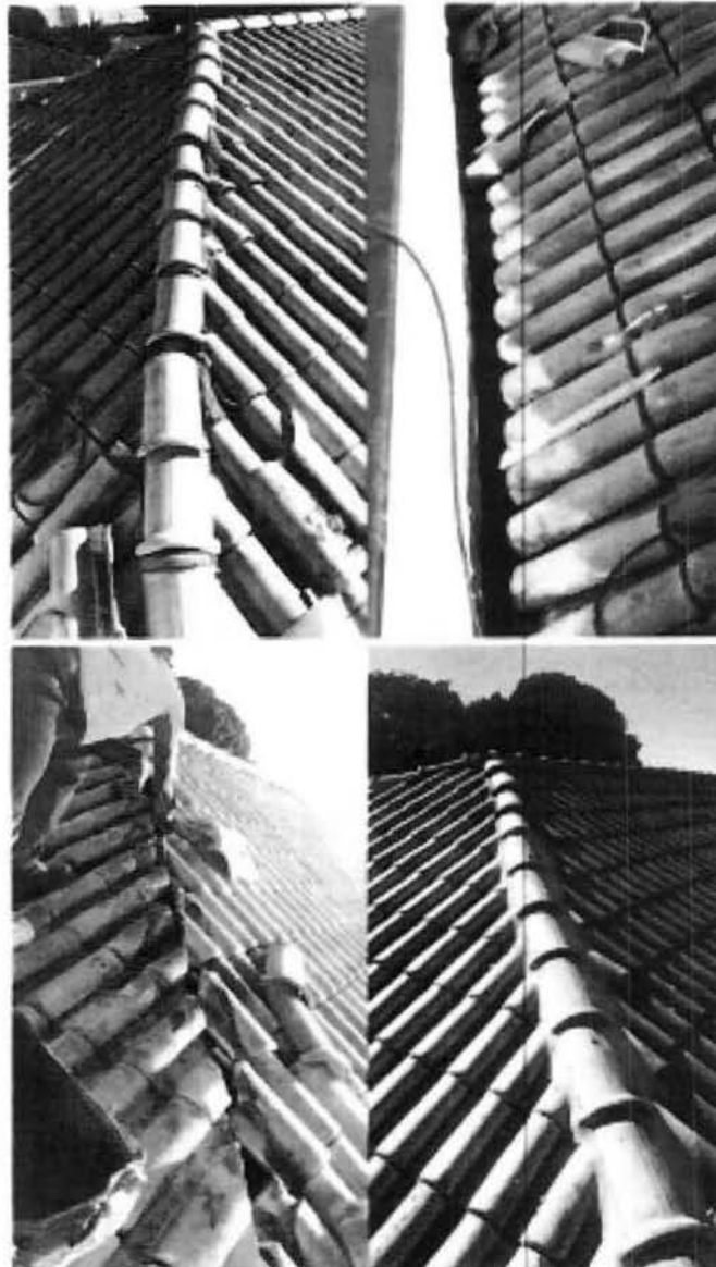
Fig. 14 – Vista da cobertura da edificação principal
