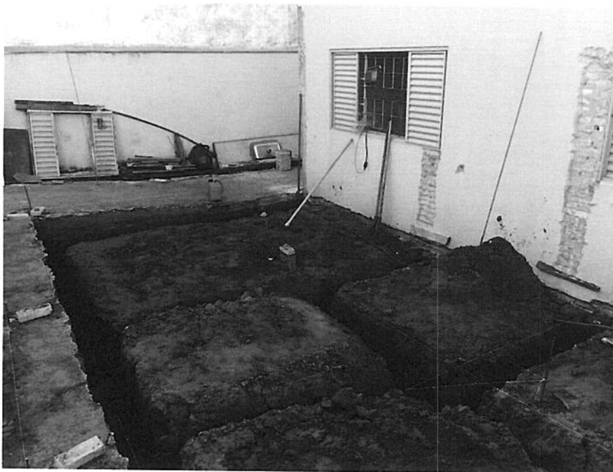
Fig.5- Abertura de vala para execução do baldrame.
