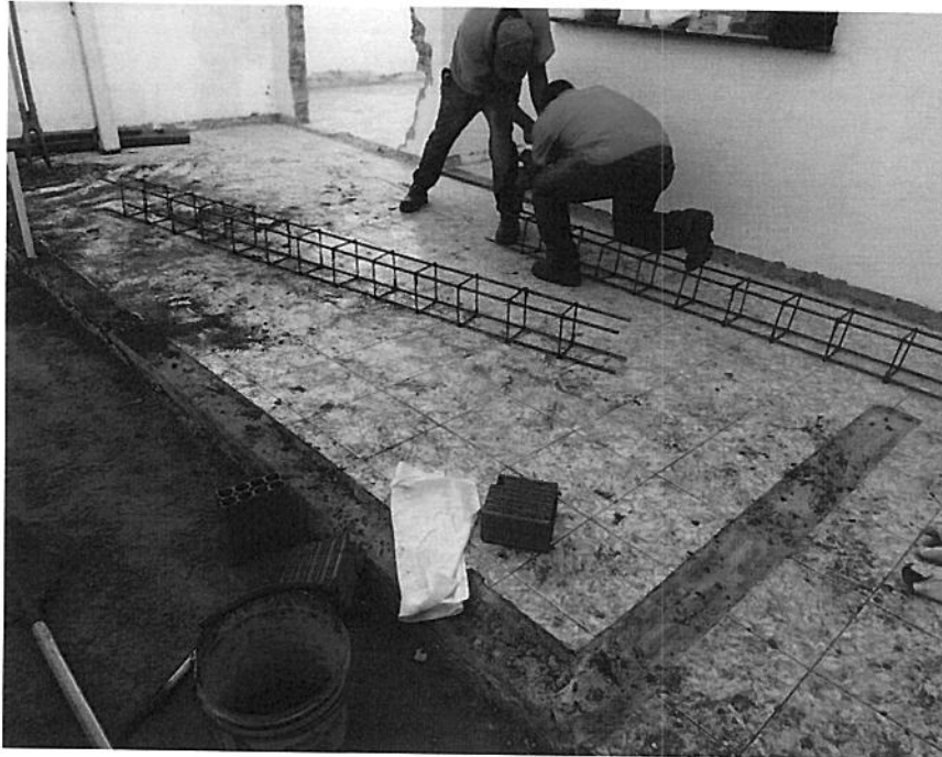
Fig.2- Montagem das armaduras em aço da viga baldrame.
