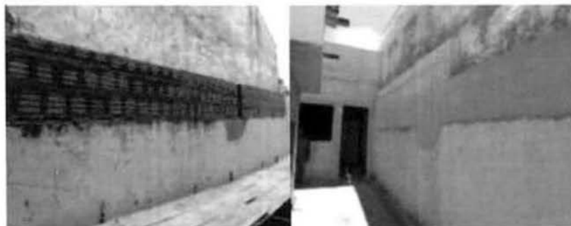
Fig.1 – Vista do muro lateral (divisa).
