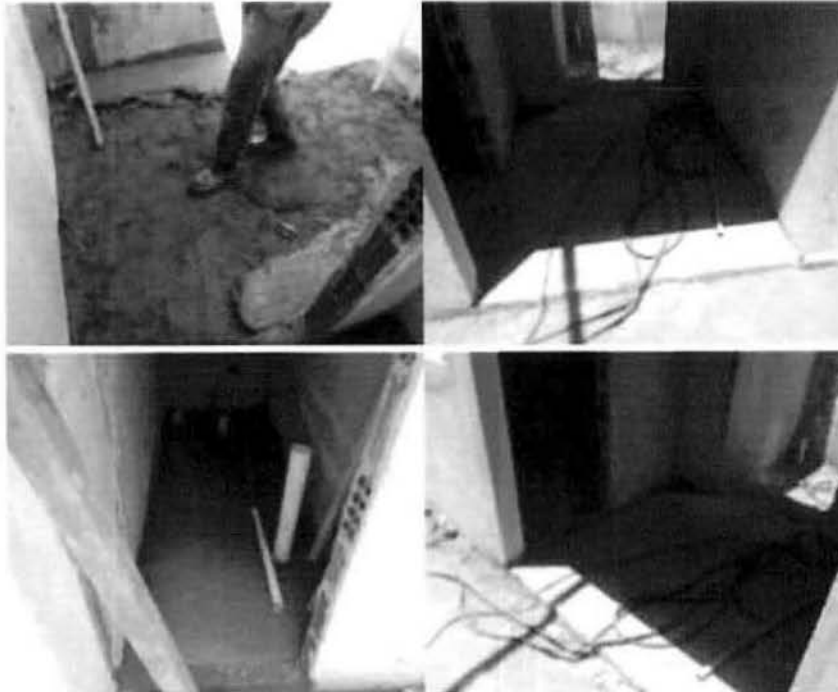
Fig. 4 – Execução do contrapiso.
