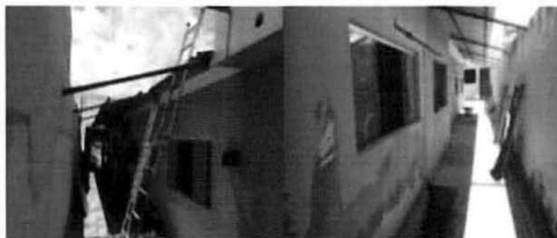
Fig.2- Vista do corredor lateral (Montagem da cobertura)
